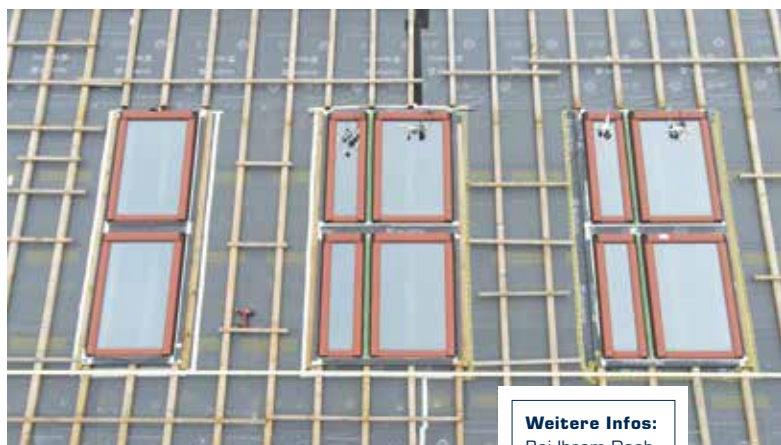
Eingebaute Fenster mit Lackierung RAL 8004 entsprechend der neuen Ziegeleindeckung
