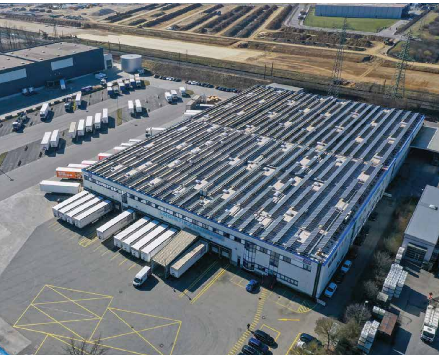
Die Lager- und Logistikhalle der Spedition Mayer in Gersthofen wurde nach einem Hagelschaden aufwändig saniert und mit zahlreichen Photovoltaikmodulen versehen
