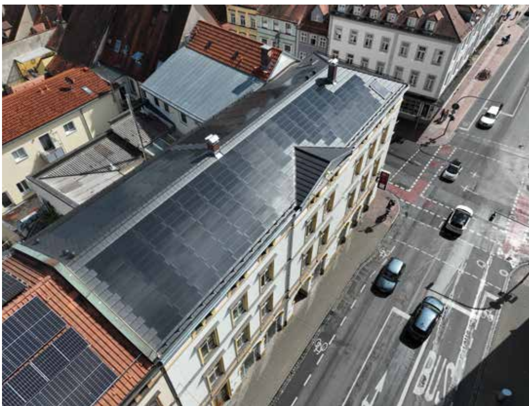
In der UNESCO-Weltkulturerbe-Stadt Bamberg kam mit dem PV-System Wevolt X-Tile von wienberger erstmals eine dachintegrierte Photovoltaikanlage auf einem denkmalgeschützten Gebäude zum Einsatz. Foto: wienberger
