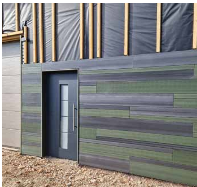
Die Montage der Paneele erfolgte mit der neuen Klammerlösung auf Holzlatten
