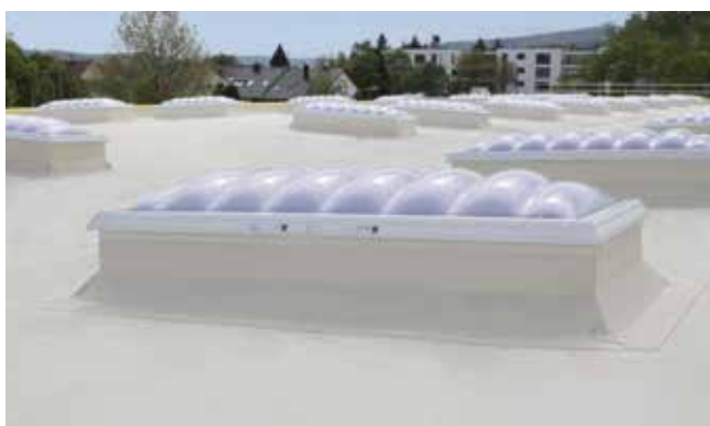
Flachdachsanierung bei Kärcher in Winnenden mit LAMILUX Lichtkuppel F100 W und Aufstockelement
