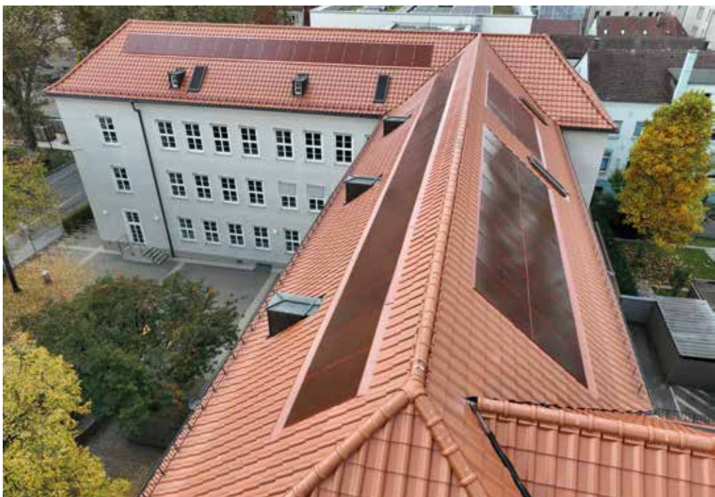
Die roten Module des PV-Systems Wevolt X-Frame passen sich optisch perfekt in historische Dächer ein. Foto: wienberger
