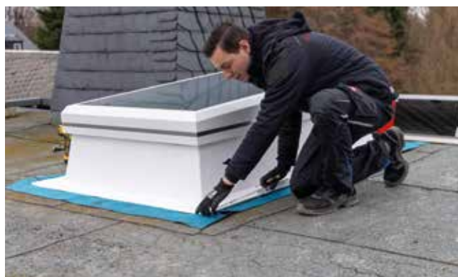
Einbau des vormontierten LAMILUX Flachdach Fensters FE 3°
