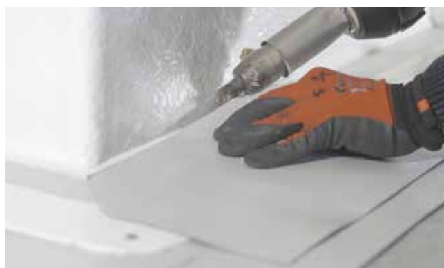
Einfache Montage der LAMILUX Aufsatzkränze dank PVC-Anschlussschiene
