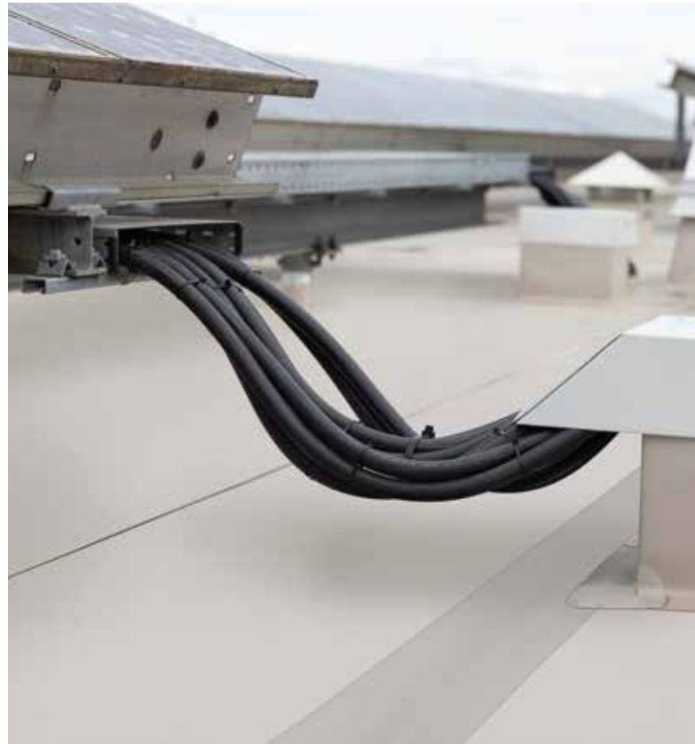
Aus dem umfangreichen Zubehörsortiment von Sika konnten auch die zahlreichen Kabeldurchführungen für die Photovoltaikanlage geliefert werden
