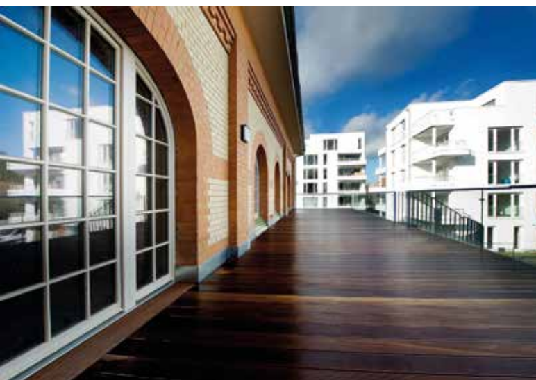
Dicht und schick – die fertige Lofterrass (Terrass nach der Sanierung)
