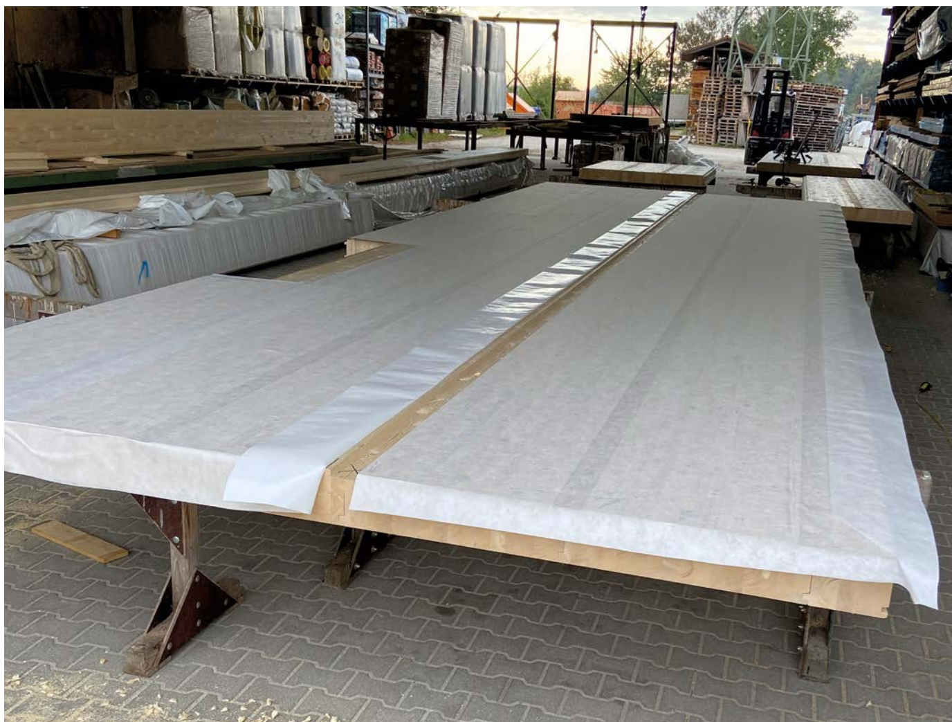
Bauzeitschutz spielt bei der Vorfertigung im Holzbau eine große Rolle
