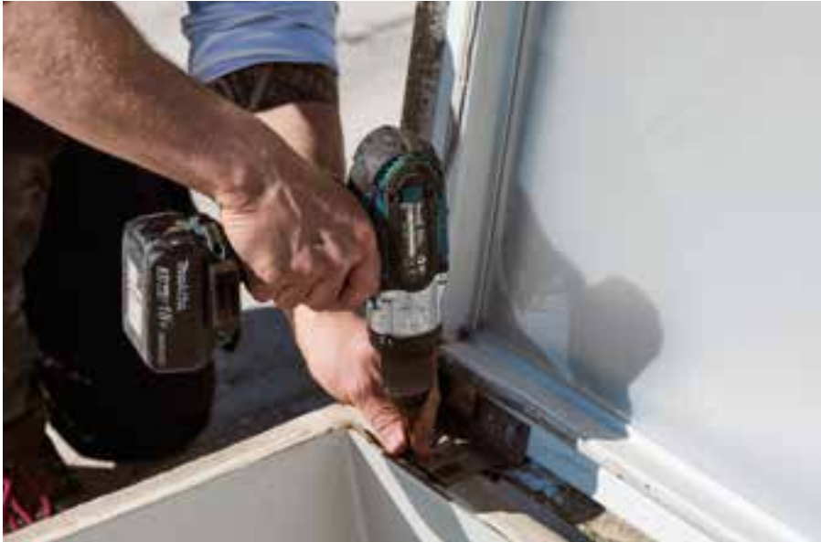
Schritt 1: Zuerst wird das veraltete oder beschädigte Oberlicht demontiert. Foto: Kingspan Light + Air
