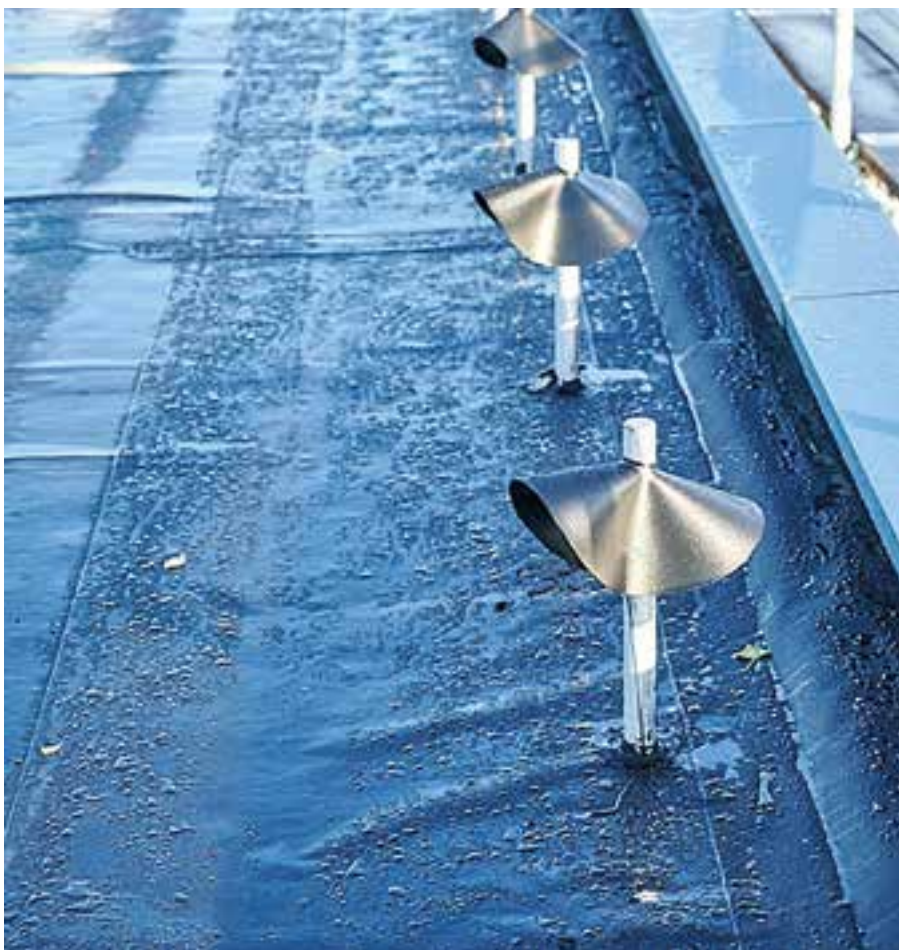
Vorgefertigte Rohreinfassungen DN 50 erleichtern die Arbeit
