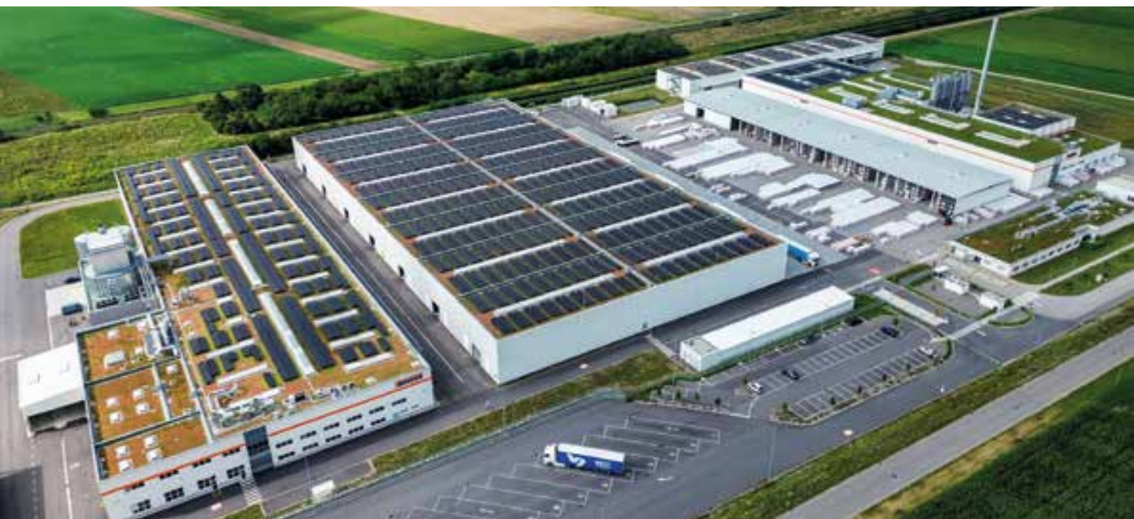
Bauder-Werk in Bruck – mit extensiver Begrünung, Regenwassermanagement und Photovoltaik
