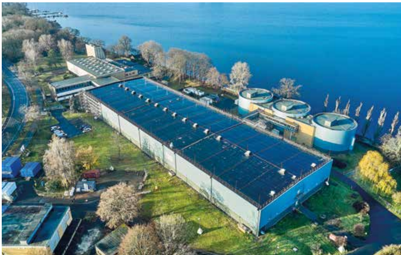
Wasserwerk Tegel der Berliner Wasserbetriebe, oben der Tegeler See
