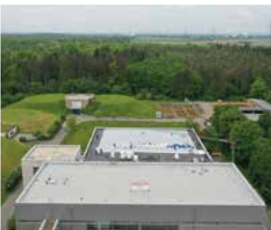
Zwei Dächer des Wasserwerks Jägersburg in Einhausen wurden mit der neuen selbstklebenden Dachbahn Sarnafil AT-18 FSA von Sika abgedichtet. © Sika Deutschland CH AG & Co KG
