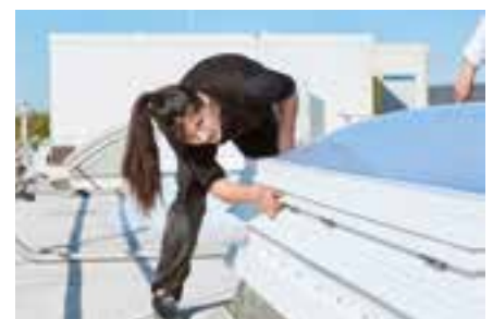
Schritt 4: Zum Schluss wird die Lichtkuppel auf dem Systemrahmen ausgerichtet und befestigt.
