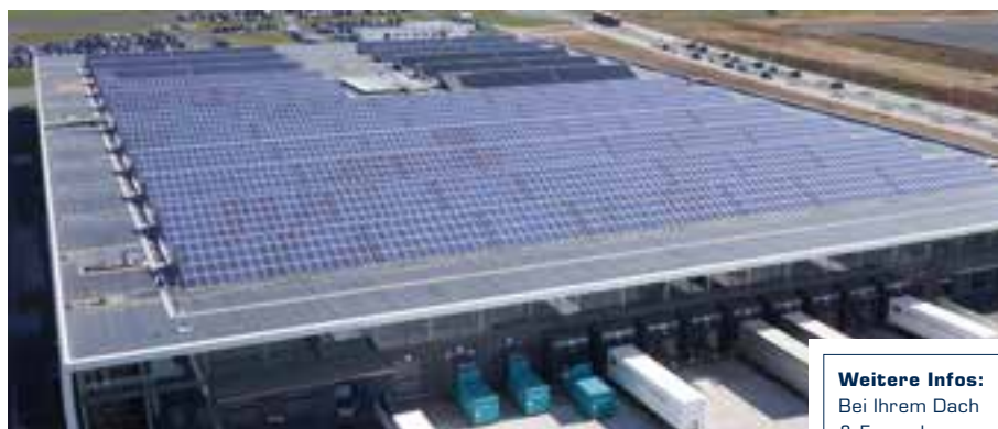
Dachobjekt in Lindlar
