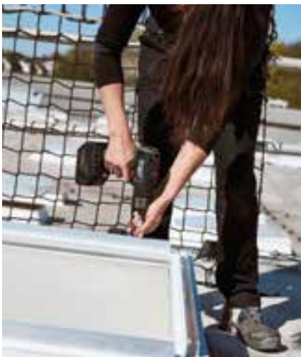
Schritt 2: Der Montagerahmen wird auf dem Aufsetzkranz ausgerichtet und mit der vorgesehenen Bohrung verschraubt. Foto: Kingspan Light + Air
