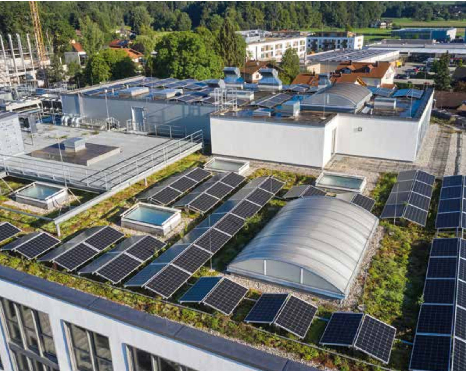
Produktions-Lagerhalle in Bruckmühl, Material: Rhepanol hg und hfk
