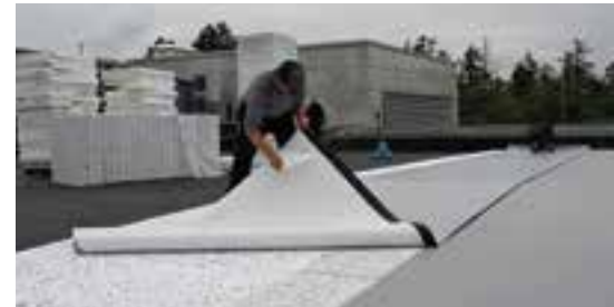
Auf die EPS-Dämmung wurde die selbstklebende Dachbahn Sarnafil AT-18 FSA ausgerollt und ausgerichtet. © Sika Deutschland CH AG & Co KG
