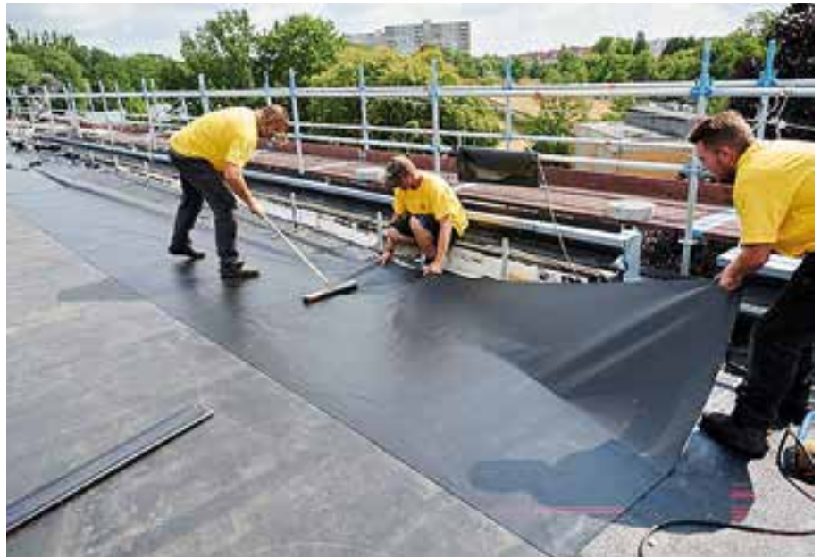
Verlegung der Wolfin GWSK – dank der Selbstklebeverlegung mit schnellem Baufortschritt
