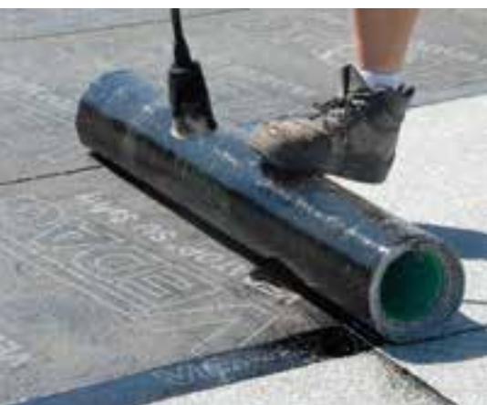
Dank BlueSpeed-Technologie energie- und zeitsparend: Verschweißung der Oberlage Vedastar Duo auf der Unterlagsbahn Vedastar SU Safety (früher Vedatop SU Safety)
